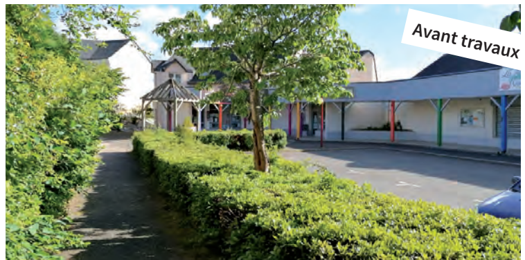
La Place des Jardinets avant les travaux
