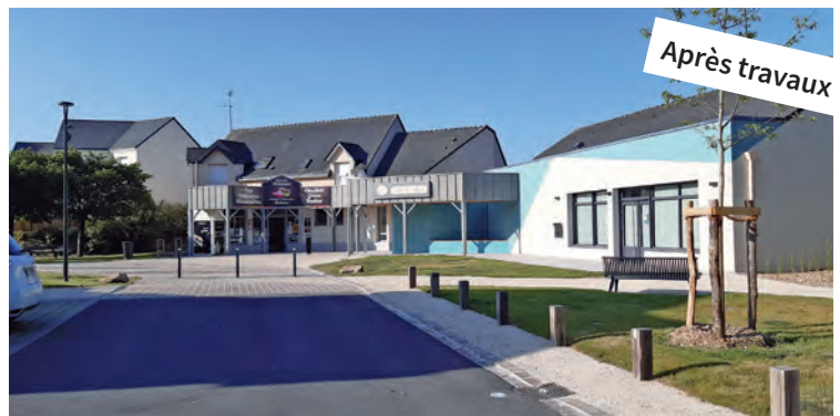
La Place des Jardinets à Saint-Léger-des-Bois réaménagée
