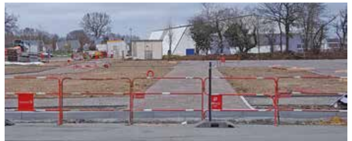
Réaménagement de la Place de la Croisée
