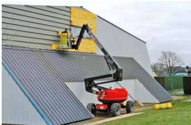
Bardage extérieur de la salle Linériis
